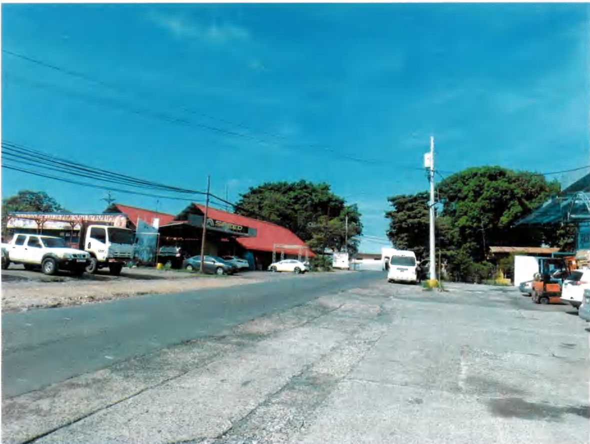
Fig. 2: Vista del área donde se iniciara la construcción del muro de tierra armada del acceso del puente por la Calle Damián Carles.
