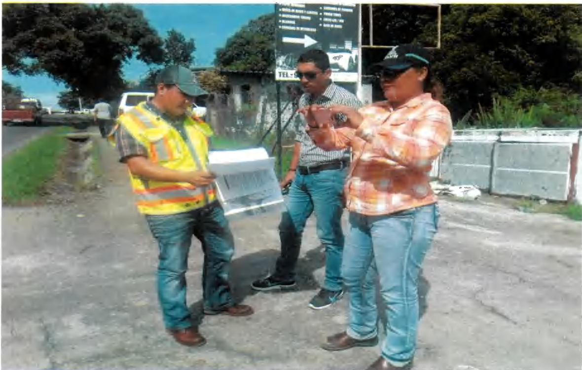
Fig. 6: Vista del personal de MiAMBIENTE y MOP durante la inspección
