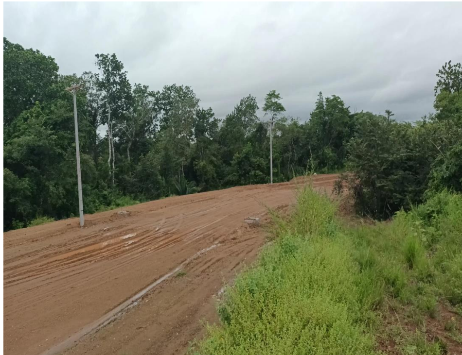
Figura 6. Vista de trabajos de nivelación para Avenida Principal
