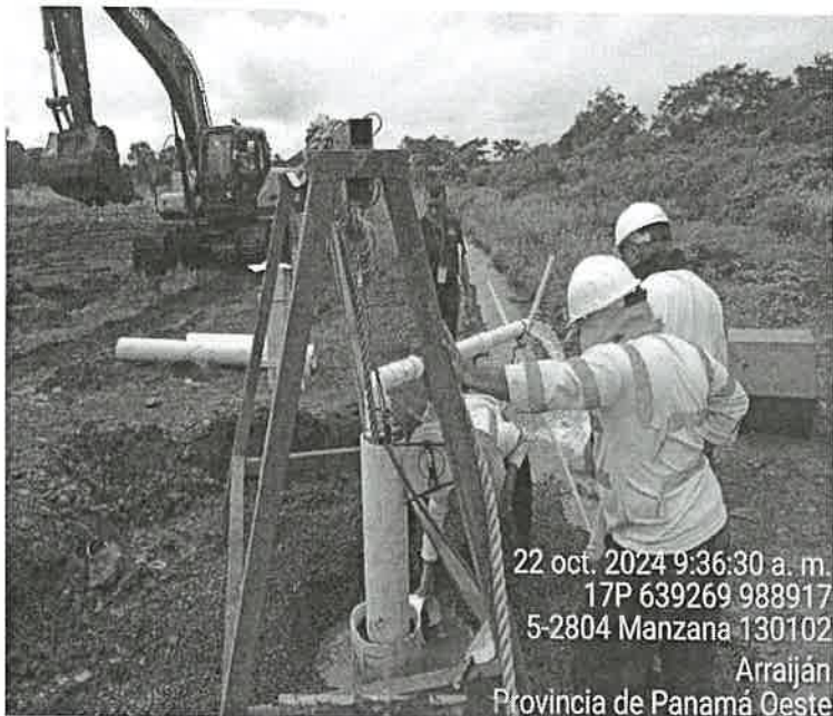
Imagen 1, 2. Recorrido del proyecto en proceso de evaluación, equipo de exploración de pozo realizando pruebas de agua, la topografía del sitio es irregular a plana, con algunas ondulaciones.
