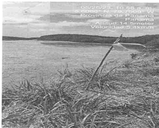
Imagen N°3. Canal de drenaje agua marina existente.
