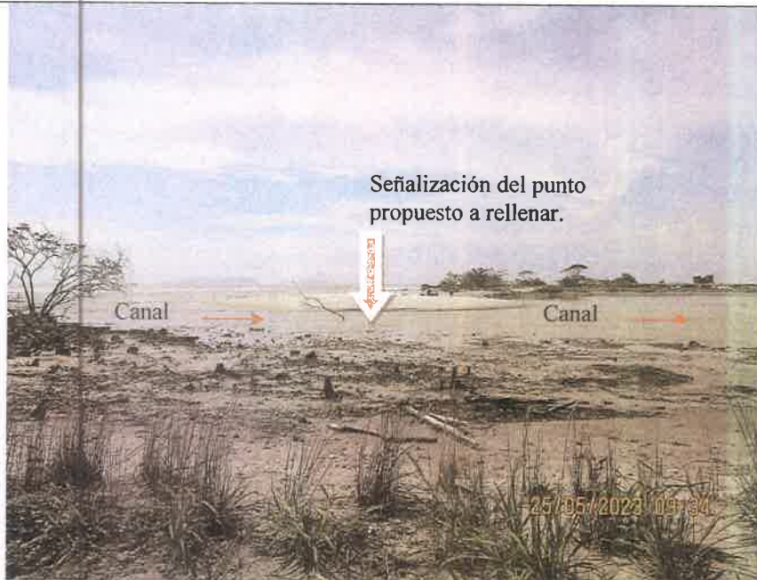
Foto 6. Demarcación del punto donde se propone rellenar.
