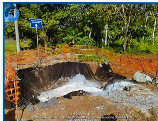
Fotografía 4: Tina de Lavado de Concreto.
