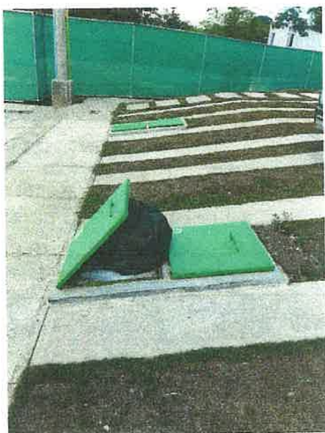
Contenedor de basura soterrado.
