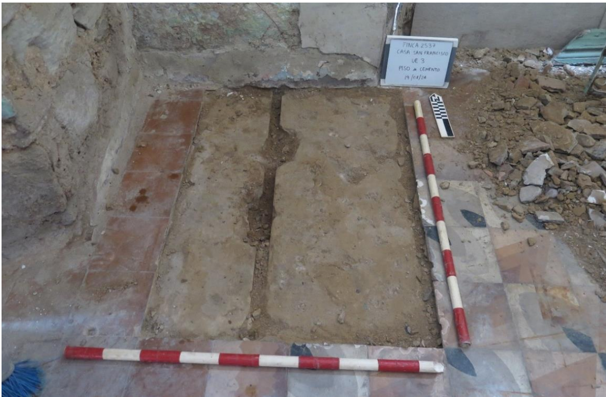
Fig. 26. Piso de cemento con ranura (R7) para un piso de tablas de maderas encontrado debajo del piso de baldosa en la UE 3.
