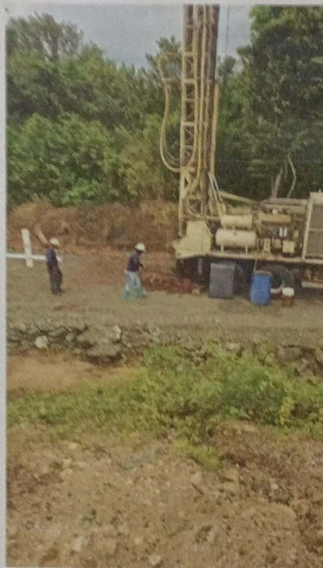
PERFORACION DE POZOS PARA LA DOTACION DE AGUA
