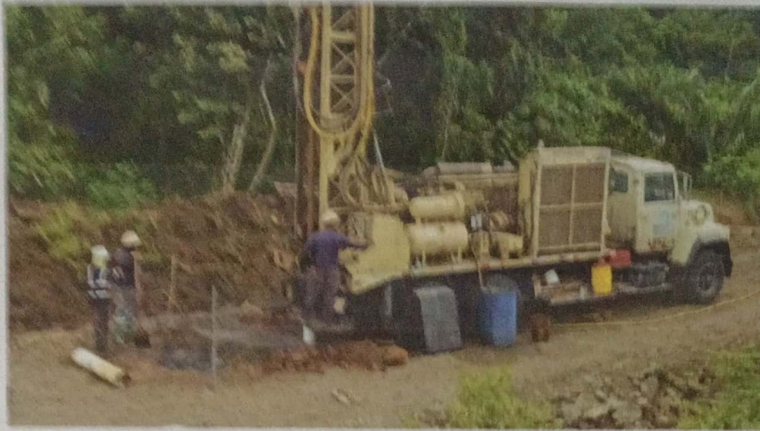
PERFORACION DE POZOS PARA LA DOTACION DE AGUA
