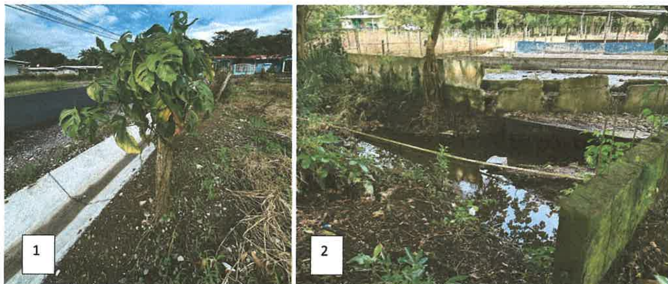
(1) Cuneta existente en la parte posterior del terreno; (2) drenaje pluvial existente
