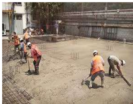
Imagen 7. Vaciado de concreto.
