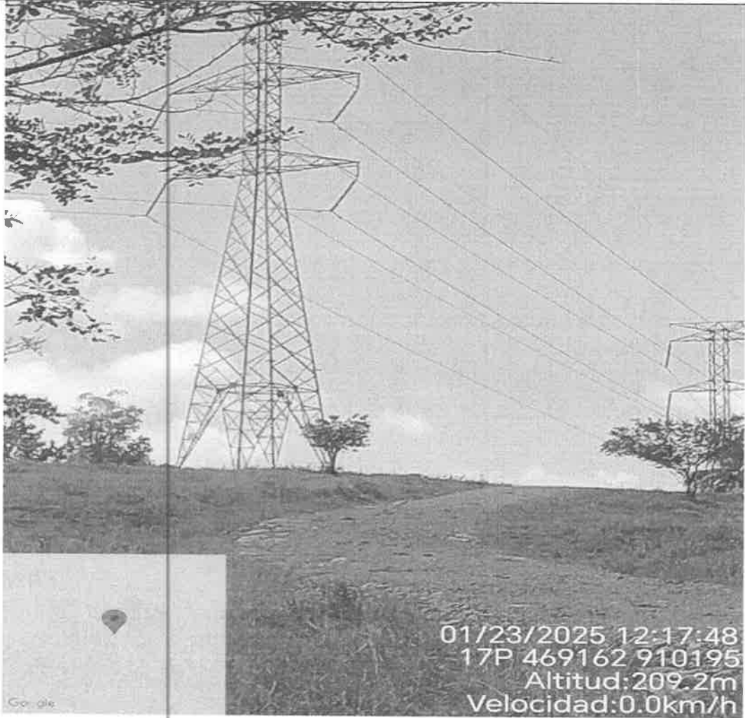
Foto. 11 Vista de la T-5621 y T-622. Ambas serán removidas y se instalará solo una, se ubicar en posición media con relación a la ubicación actual.
