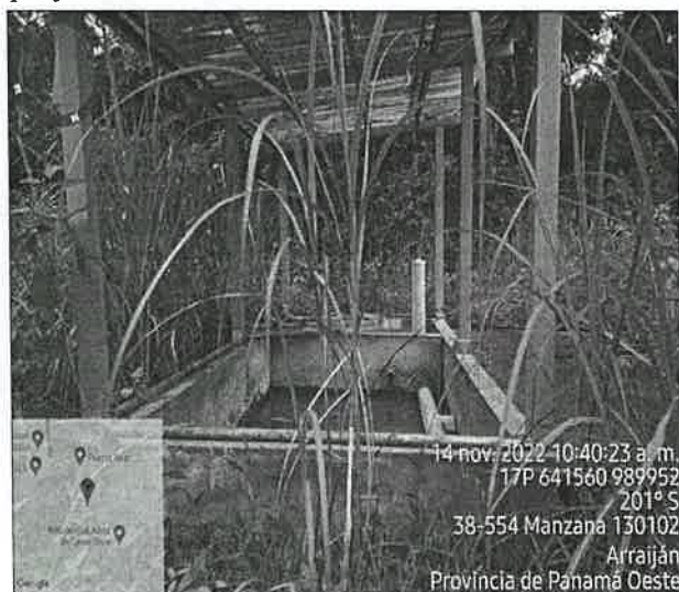
Imagen 6 y 7. PTAR del proyecto Cat. I "PH Forest Hills", se observa que mantiene agua residuales, sin embargo el sistema electrico no funciona. El Ing. Gilberto Ortiz nos indica que a esta PTAR se le construirá un nuevo modulo adicional para el proyecto Cat I "Valle Lindo".
