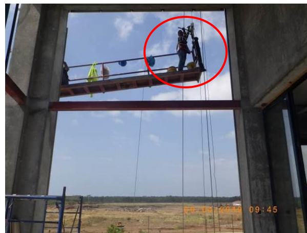
Imágenes 5 y 6. Vista de los trabajadores utilizando arnés y línea de vida, elementos necesarios para labores en altura
