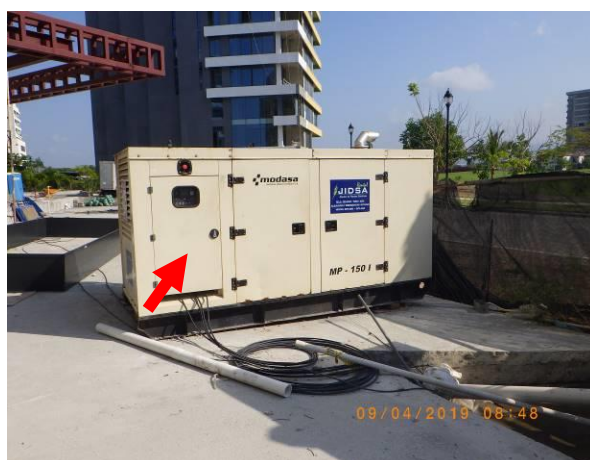
Imagen 8. Vista del generador eléctrico, sin noria de contención
