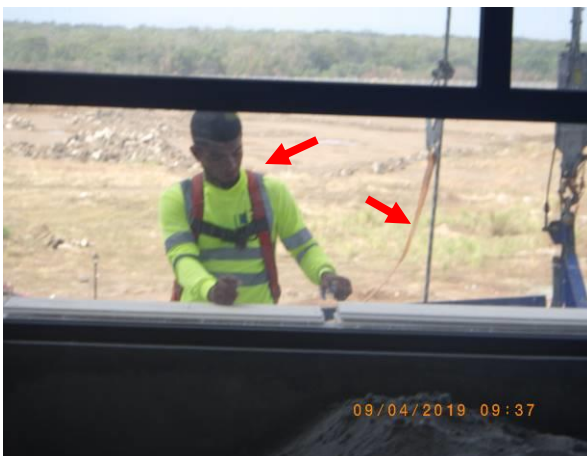
Imágenes 5 y 6. Vista de los trabajadores utilizando arnés y línea de vida, elementos necesarios para labores en altura
