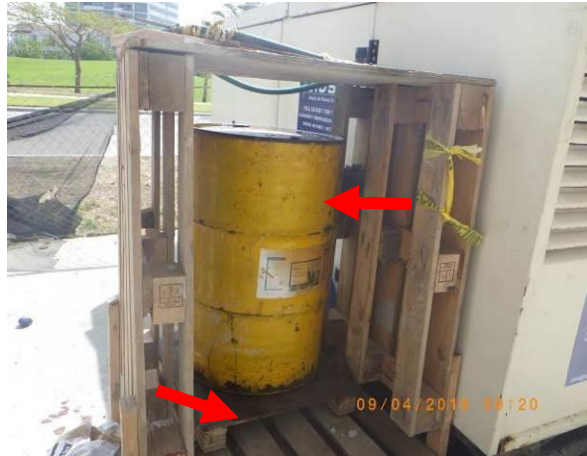
Imagen 9. Vista del tanque de almacenamiento de diésel ubicado en el proyecto, sin un medio de contención adecuado
