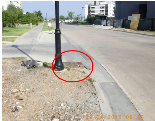
Imagen 15. Vista de la rejilla de drenaje pluvial, cubierta por material de construcción
