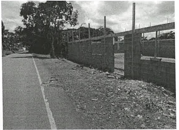
Imagen 2: área de servicios sanitarios, se observa la instalación de sistema de plomería y el levantado de paredes de concreto, con bloques de 4\"/> Fecha: 07-09-2022 Foto: Jean Peñaloza
