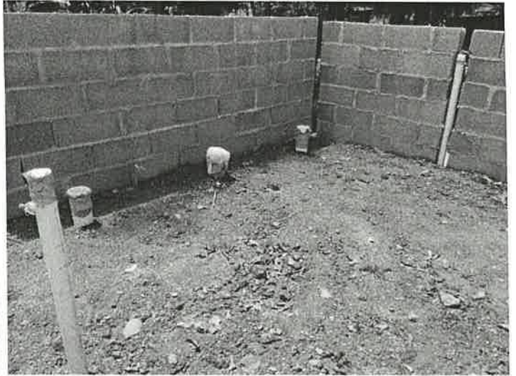
Imagen 2: área de servicios sanitarios, se observa la instalación de sistema de plomería y el levantado de paredes de concreto, con bloques de 4\"/> Fecha: 07-09-2022 Foto: Jean Peñaloza
