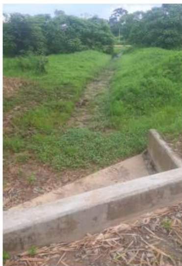
Fig. 2 Canal formado debido a nuevo cabezal construido
