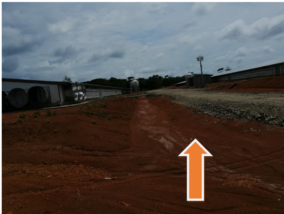
CALLES CON TOSCA Y INICIO DE SIEMBRA DE PIÑA COMO MEDIDA DE CONYROL D EROSION
