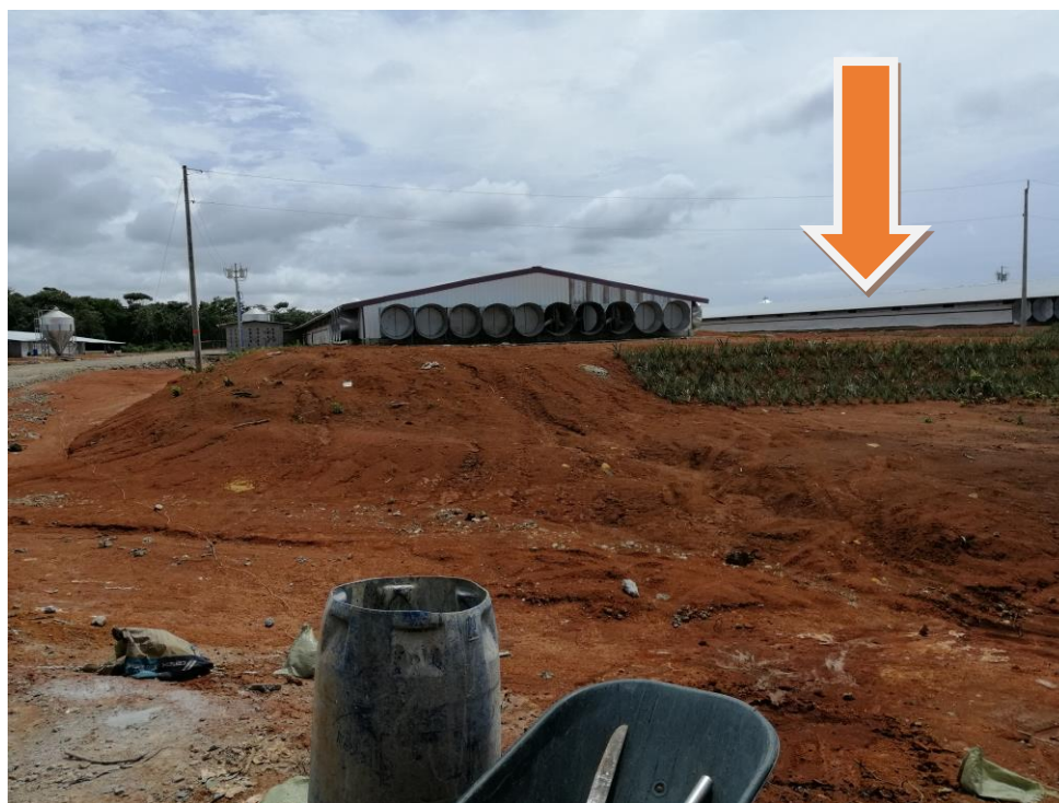
CALLES CON TOSCA Y INICIO DE SIEMBRA DE PIÑA COMO MEDIDA DE CONYROL D EROSION
