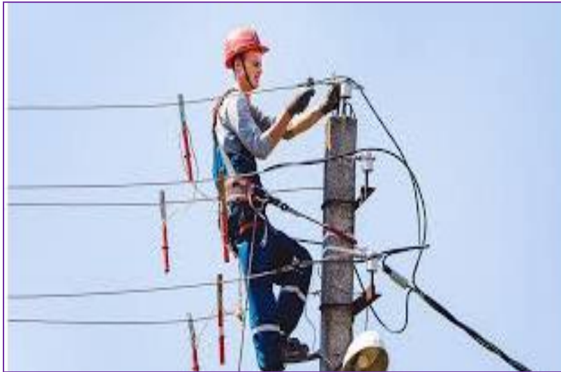
Imagen 4.20 Tendido de conductores
