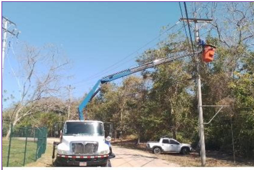
Imagen 4.16 Montaje de postes
