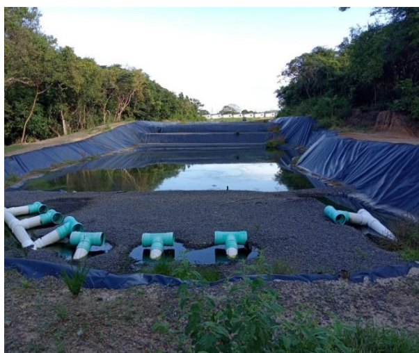
Estado de las tinajas construidas para el sistema de la PTAR madre aprobada inicialmente en el estudio.
