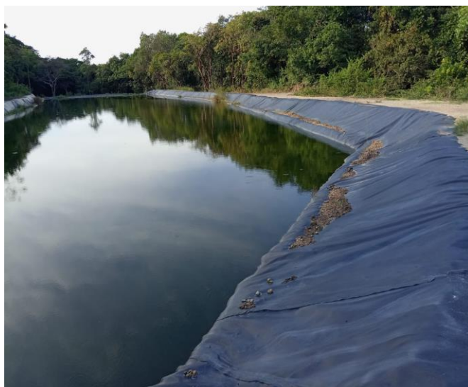
Estado de las tinajas construidas para el sistema de la PTAR madre aprobada inicialmente en el estudio.
