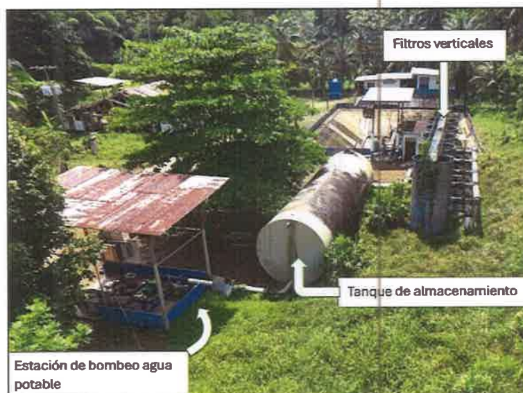
Figura 38. Filtros verticales, tanque de almacenamiento y estación de bombeo de agua potable.
