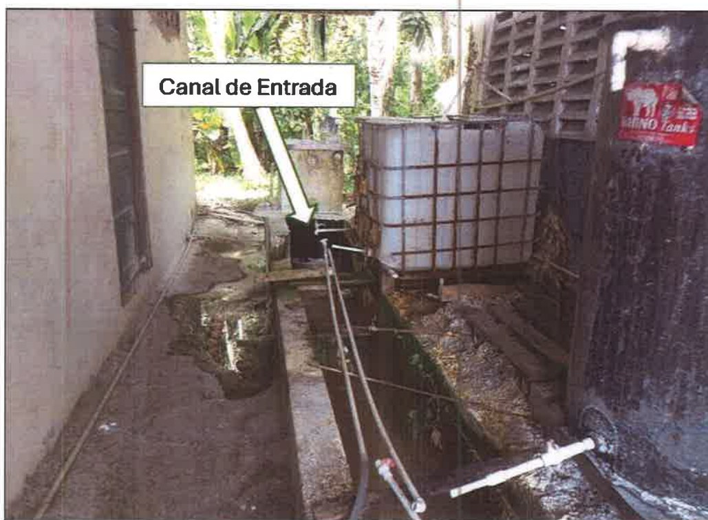
Figura 33. Canal de Entrada - PTAP Quebrada Nigua.
