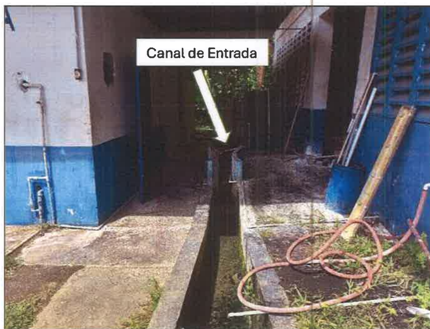
Figura 28. Canal de Entrada - PTAP Quebrada Nigua.
