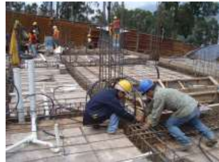
Imagen 5. Instalación de sistemas de tubería.
