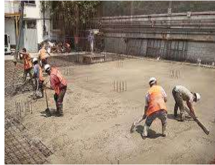
Imagen 7. Vaciado de concreto.
