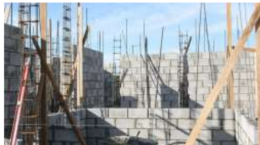
Imagen 8. Levantamiento de muros y paredes.
