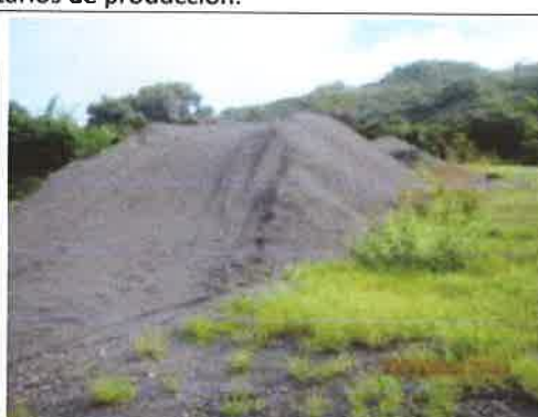
8. Patio de acopio de agregados pétreos. No se observó en el proyecto suelo desnudo sin vegetación, por lo que no hay aportes de sedimentos a las zanjas de drenajes próximas.
