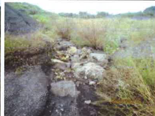
9. Perímetro de protección contra los procesos de erisión y sedimentación en el patio de agregados pétreos (Vegetal, rocas y árborización).
