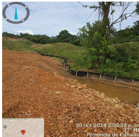
Imagen No. 1 conformación final de taludes
