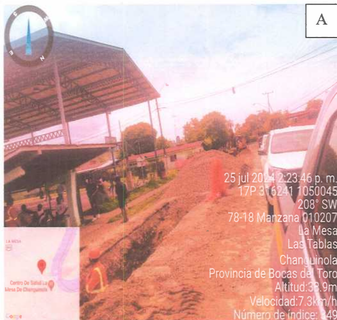
Imagen 5. Inicio de trabajos de instalación de tuberías de conducción en las comunidades A: Las Mesas y B: Washouth.
