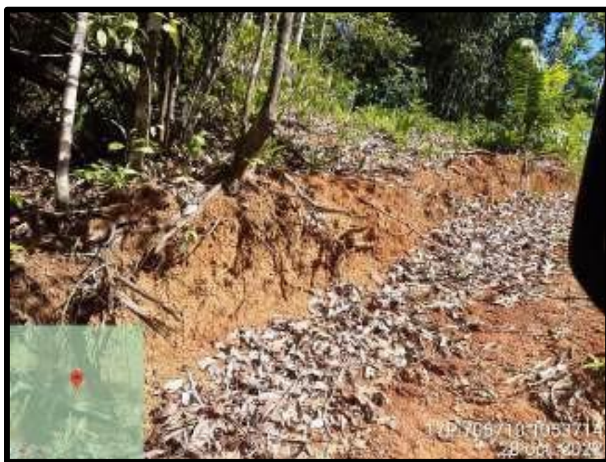
Figura 6-8. Erosión por la construcción de camino inicial. Fuente: Equipo consultor
