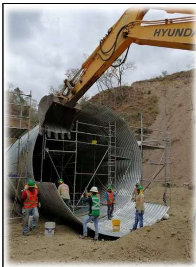
Figura 13. Montaje y/o instalación de la estructura.
