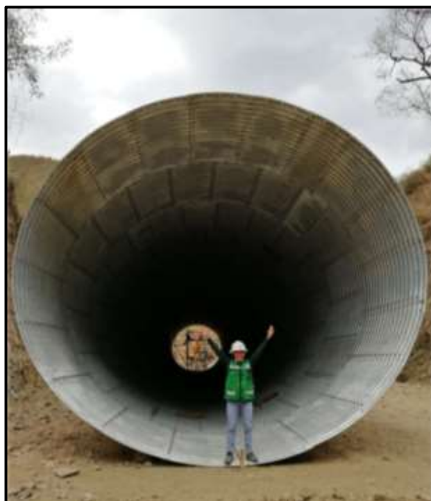
Figura 1. Estructura superluz tipo elipse metálica galvanizada.
