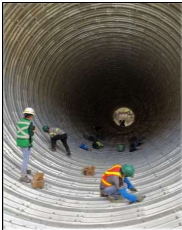
Figura 11. Ensamblado de la estructura.
