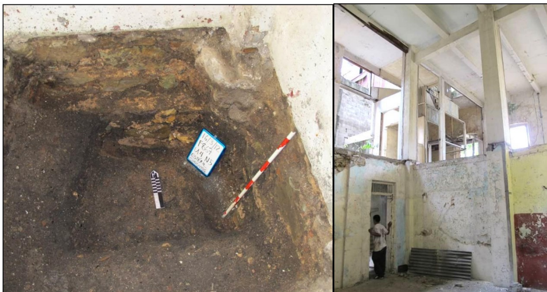
Figura 20) Excavación de la unidad 4 vista desde el sur. En la esquina entre ambos muros está un refuerzo de concreto armado. A la derecha, intersección de los muros medianeros a lo interno del edificio 6-18, vista desde la esquina noroeste. Nótese cómo los muros solamente se elevan hasta el piso del primer alto. También es de notar la losa de concreto para el segundo alto.
