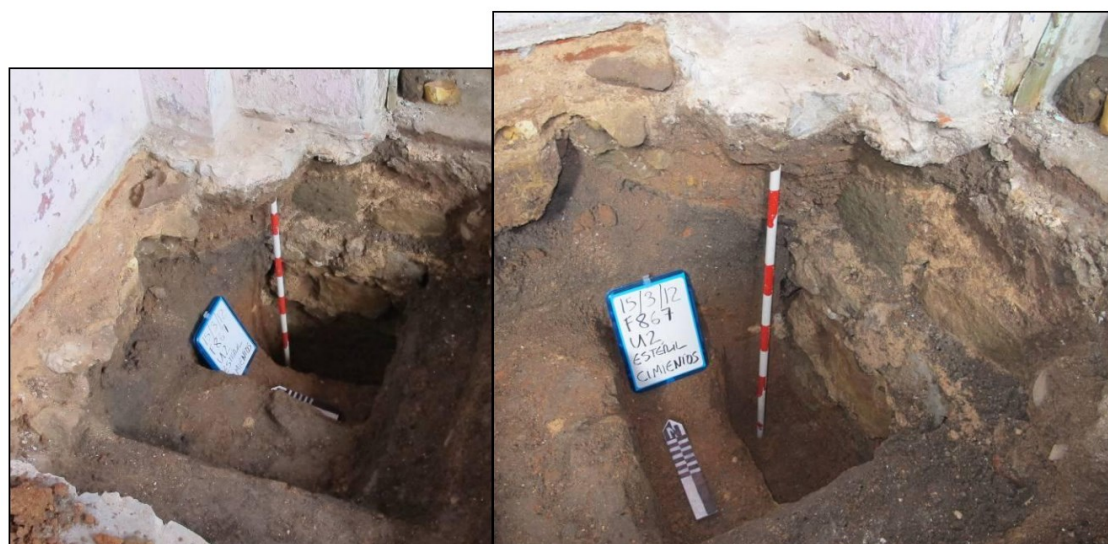
Figura 16) Final de la excavación de la unidad 2. Nótese la profundidad del cimiento del muro norte-sur versus la del cimiento que corre este-oeste.
