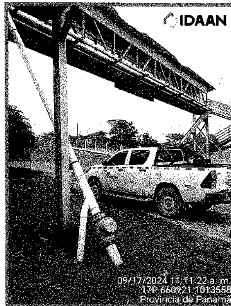
Fotografía N° 3 Punto de conexión con la línea existente, hacia tanque de almacenamiento.
