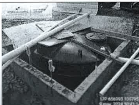
Figura No.21: Véase avance en la instalación de tanque séptico.
