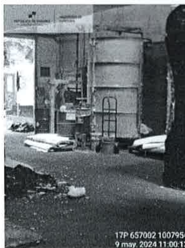
Figura 3: Véase tanque de reserva de polirol sobre plataforma.
