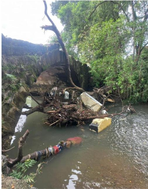
**Imagen de Puente del Rey afectado por escombros vegetales y desechos que se trasladan por el Río Abajo, estas afectaciones serán mitigadas con la instalación de las barreras flotantes que retendrán estos desechos.**
