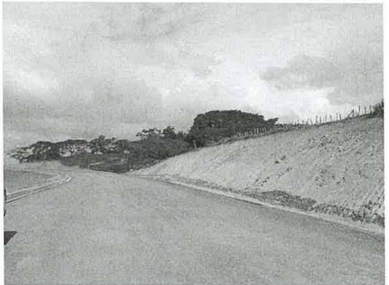
Imagen N°2: final del proyecto, se observa el talud de la carretera, costado izquierdo (área N° 1), dicho talud, tiene una altura promedio de 2.50 m, (1+100). Foto Tomada por: Jean C. Peñaloza. Fecha: 21/03/2022
