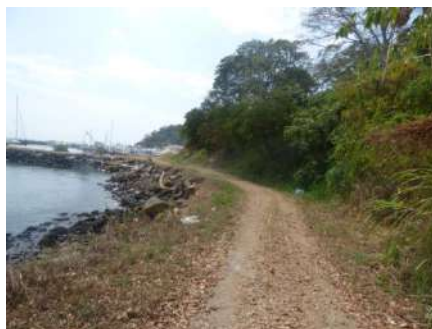
Ilustración 61 Vista general. Camino en área alterada por relleno.
