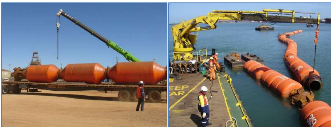
Figura 68. Transporte y ensamble de tubería flotante
