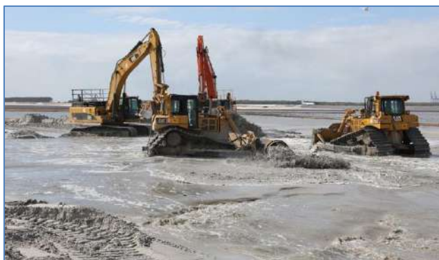
Figura 19. Distribución del material en el área de relleno
