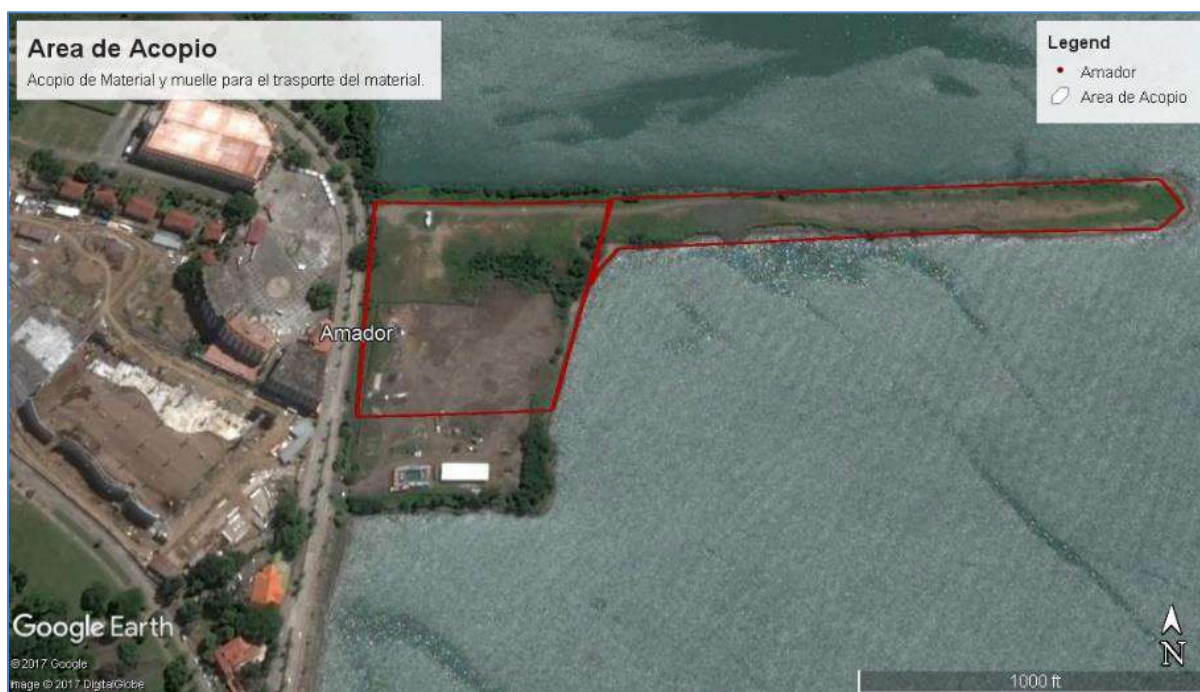
Figura 1. Relleno existente frente al Centro de Convenciones Figali
