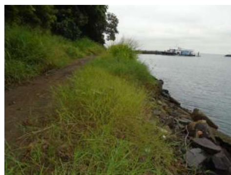
Ilustración 56 Vista general. Alterado. Camino en área alterada por relleno.
