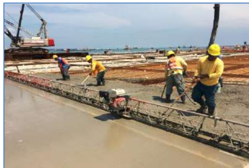
Figura 26. Vaciado de la superficie del muelle
