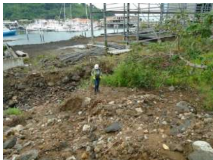
Ilustración 53 Vista general. Zona alterada por relleno.
