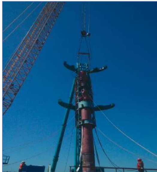
Figura 23. Hincado de Forro por Martillo Hidraulico
