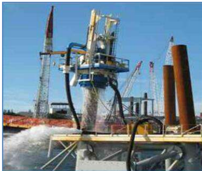
Figura 24. Perforación para construcción de pilas
