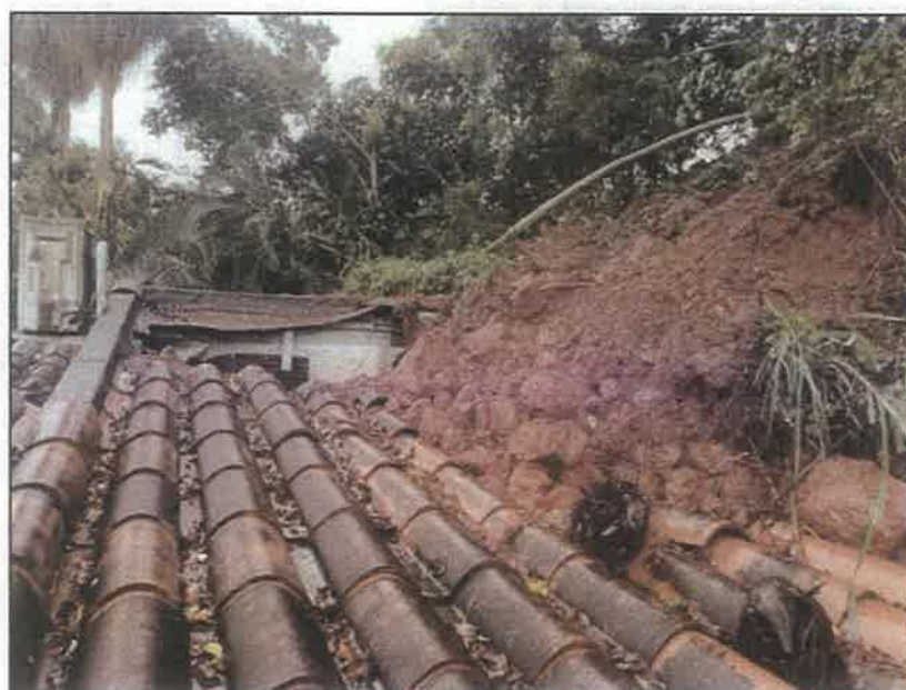
Vista de los daños ocasionados en la vivienda M7 y M6, donde se observan que parte del material deslizado sobre el techo del estudio de la vivienda M7.
