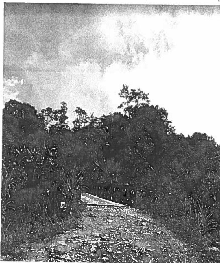
Foto No. 4 – Puente temporal tipo Bailey sobre la quebrada Chevo.
