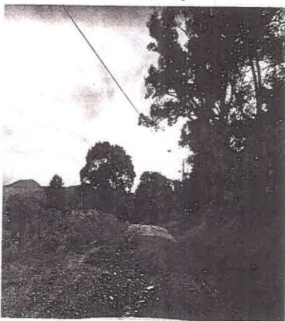
Foto No. 3 – Parte donde el material selecto ha sido lavado por falta de cunetas que conduzcan las aguas pluviales.
