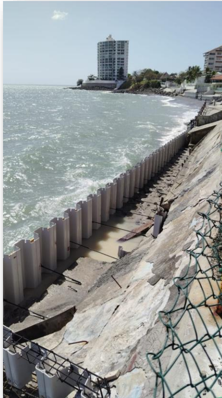
Vistas parciales del avance del muro de tablestaca
