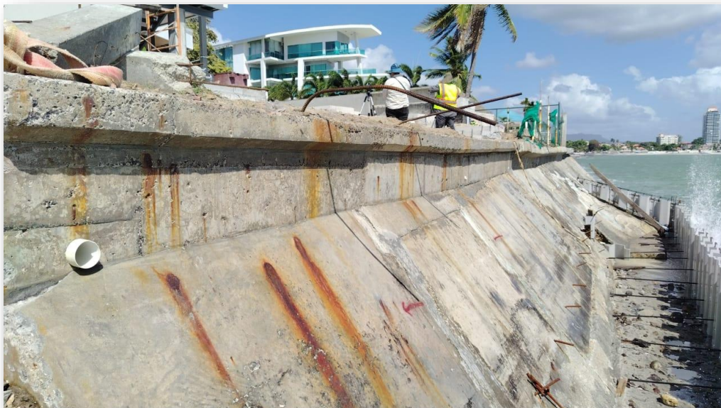
Vistas parciales del avance del muro de tablestaca
