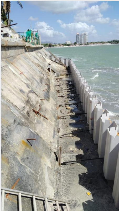
Vistas parciales del avance del muro de tablestaca
