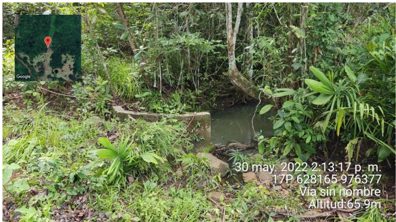
Foto 2: Vista del cabezal de la tubería existente a remover para construir el vado
