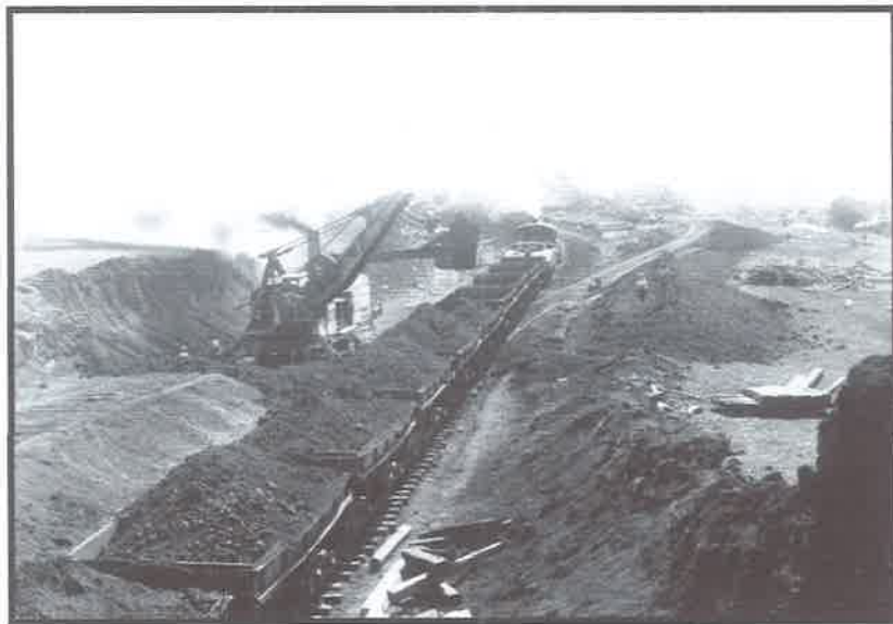
Ilustración 10: Construcción del canal
