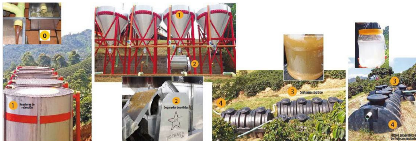
Figura 2. Partes planta de tratamiento de aguas mieles del proceso de beneficio del café.
