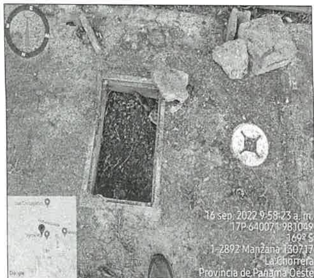
Imagen 5. Registro para sistema de agua potable y agua servidas.
