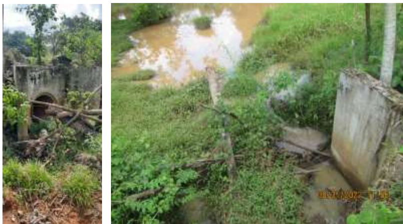
La quebrada no tiene el curso de diseño de la tubería de alcantarilla, en época seca, en época de lluvia descarga por la tubería de alcantarilla (Foto derecha).
