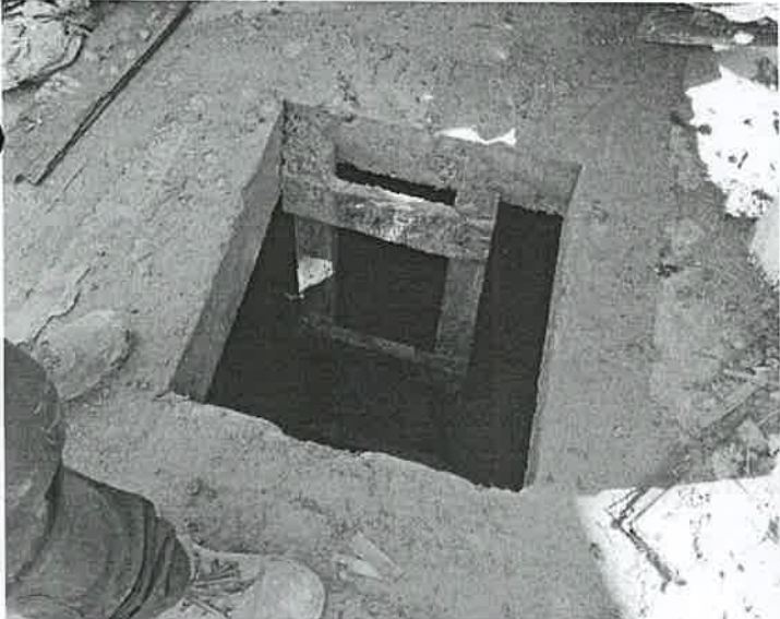
Imagen: 3: sistema de tanque séptico, localizado en la parte frontal de la infraestructura Fecha: 05-12-2022 Foto: Jean Peñaloza
