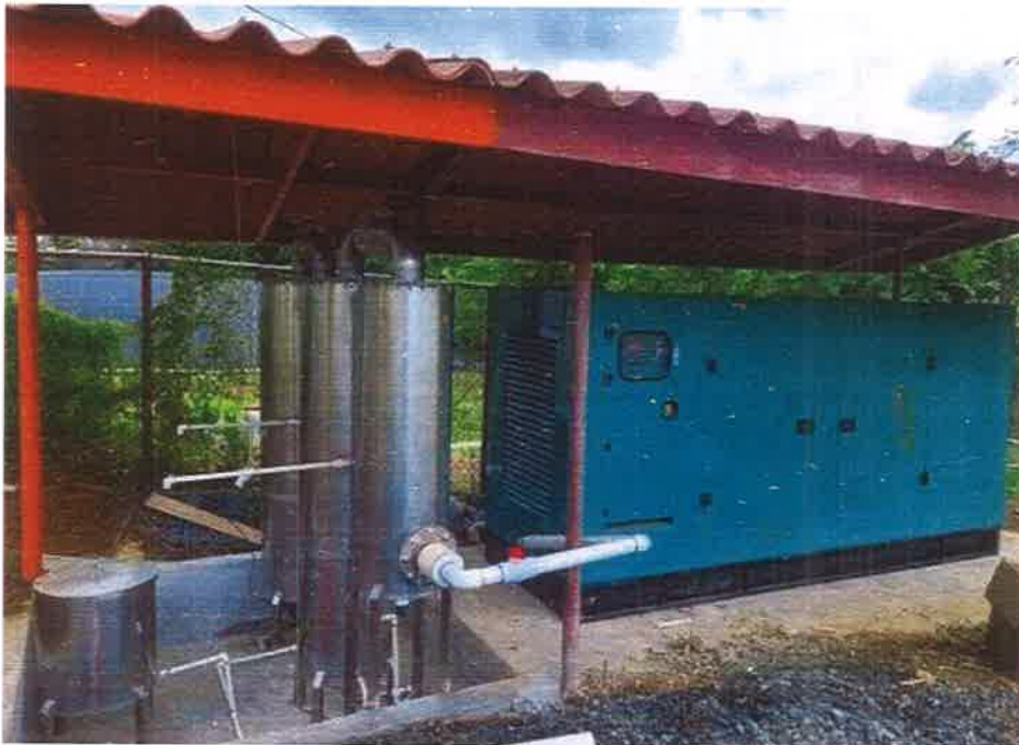
Foto 1. Ejemplo de un Generador funcionado a Biogás, Los Santos, Panamá. Sistema de Biodigestor y generador Instalado por Ing. Juan R Carrasco. Los Santos, Panamá 2024.
