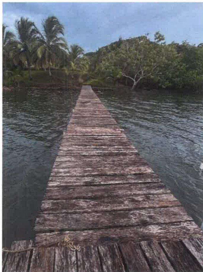
Figura 1. Atracadero 1: Estructura existente en condiciones aceptables, con pilotes de concreto/pvc que sólo requieren limpieza, y plataforma con algunas maderas que requieren ser reemplazadas y reforzadas, ubicado en un área abierta con fondo de mar arenoso con algo de lama sin presencia de manglar y el pasto marino no se verá afectado porque el fondo del mar no conllevará ningún tipo de intervención (no se cambiarán ni renovarían los pilotes existentes); por ello, se recomienda mantener el diseño y ubicación actual para no aumentar el impacto que podría causar el cambio de ubicación.
