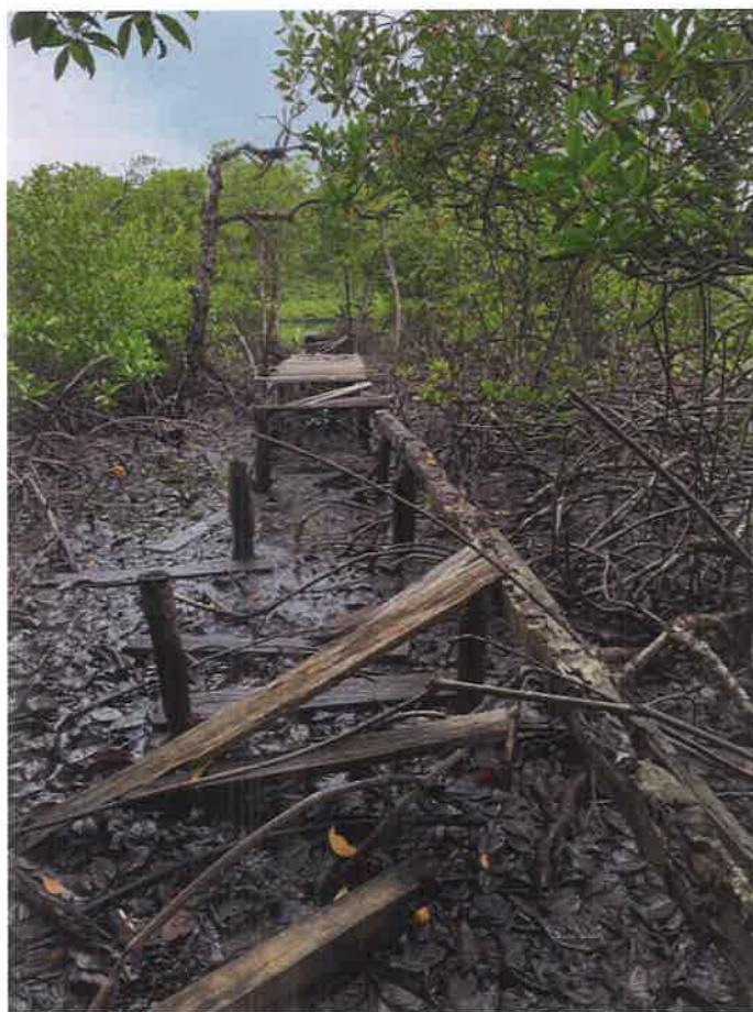
Figura 2. Atracadero 2: Estructura existente con pilotes y plataforma de madera en pésimo estado (en descomposición) que requiere renovación completa, ubicado en un área con apertura y espaciamiento existente en medio de mangles (área abierta) con fondo de mar con lama (lodo) sin presencia de pasto marino a ser afectado por la reconstrucción del atracadero. Por ello, se recomienda mantener el diseño y ubicación actual para no aumentar el impacto que podría causar el cambio de ubicación.
