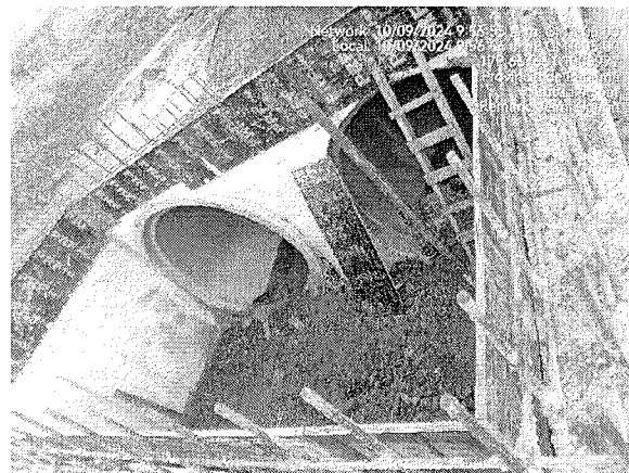
Foto N° 6. Construcción del encajonamiento del cauce hídrico y drenaje que atraviesa el proyecto (acumulación de sedimentos).
