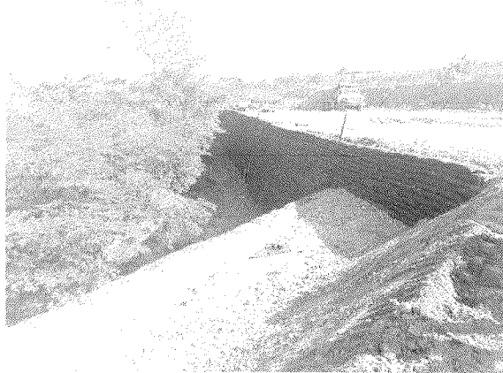
Foto N° 2. Fase I, construcción de un muro denominado Flex MSE (a base de bolsas que contienen tierra negra, tierra del área y arena).
