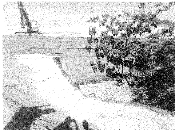
Foto N° 3. Fase II, construcción de un muro de contención utilizando el sistema Terramesh.
