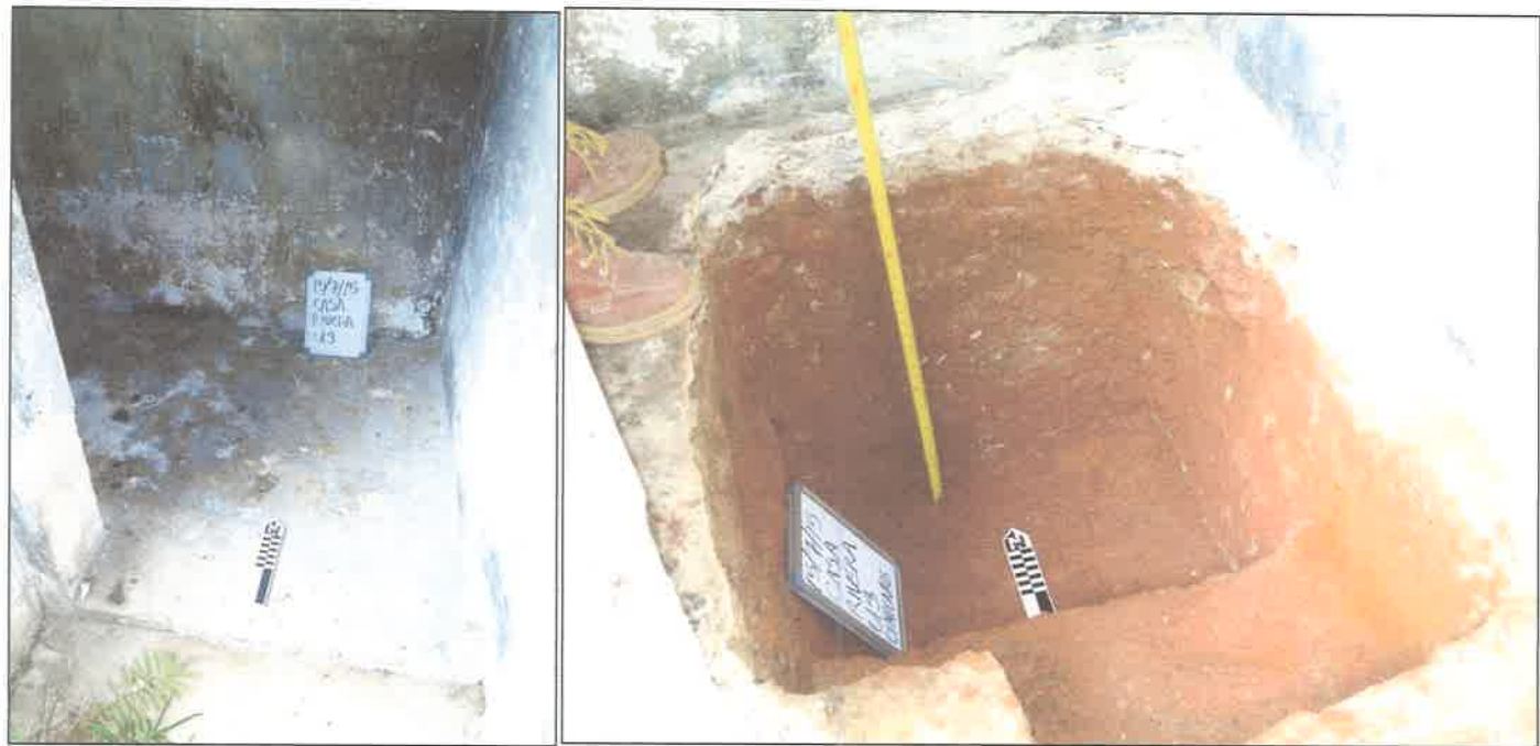
Excavación de la unidad 3 de la Casa Rivera. Nótese como el cimiento profundiza en los estratos estériles y se asienta en el roca madre al fondo.
