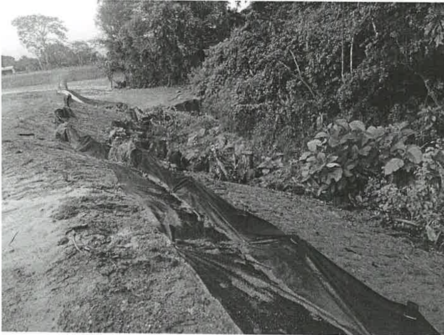
Imagen 1, 2, 3: visuales generales de distintos ángulos del terreno donde se evidencia un relieve ligeramente plano, carente de vegetación en todos sus aspectos, colocación de barreras naturales y de línea de malla para contención, a fin de evitar sedimentación a la fuente hídrica colindante, respetándose el área de protección del mismo. Fecha: 15/08/2022. Foto: Jean Peñaloza.
