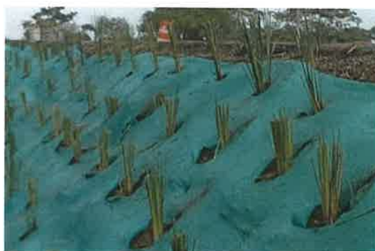
Uso de Vetiver para taludes y malla geotextil para reforzamiento de suelos.
