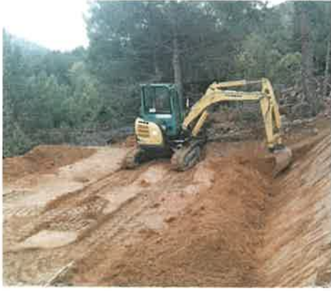
Compactación de suelo con maquinaria
