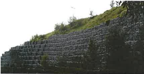
Modelos de posibles muros de contención a construir en el sitio para la estabilización de taludes
