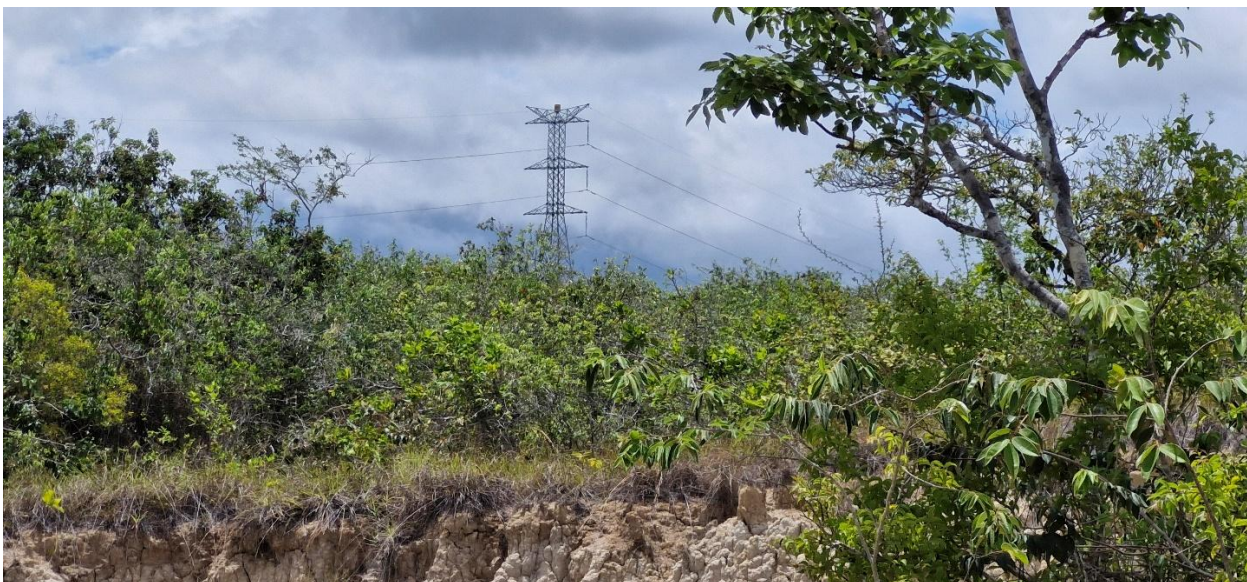
Fotografía N° 1: torre de la Línea 230 kV Toabré – Antón IV con un solo circuito conectado (tres conductores).
