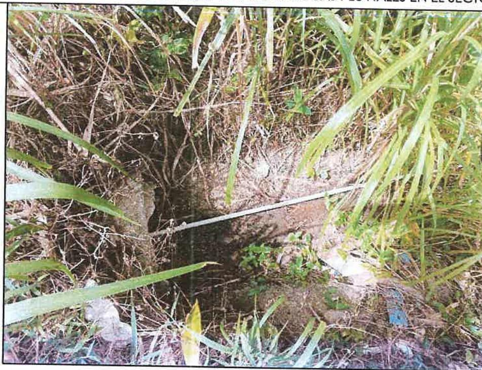
IMÁGENES DE LAS CUNETAS QUE SE ENCUENTRAN EN EL LUGAR, LAS MISMAS NO CUENTAN CON CAPACIDAD SUFICIENTE PARA EVACUAR LAS AGUAS PLUVIALES EN EL SECTOR.
