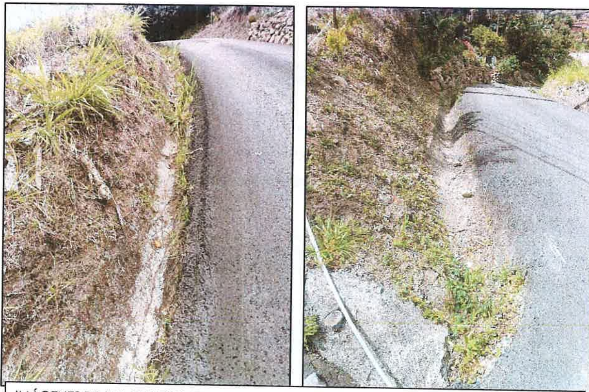
IMÁGENES DE LAS CUNETAS QUE SE ENCUENTRAN EN EL LUGAR, LAS MISMAS NO CUENTAN CON CAPACIDAD SUFICIENTE PARA EVACUAR LAS AGUAS PLUVIALES EN EL SECTOR.
