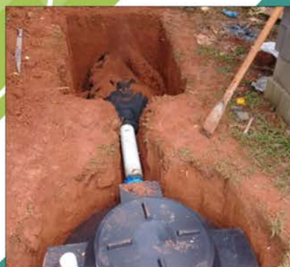
Conexión de tuberías
