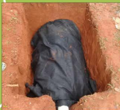
Cubrimiento con geotextil
