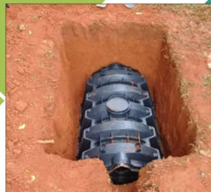
Colocación túnel GRAF
